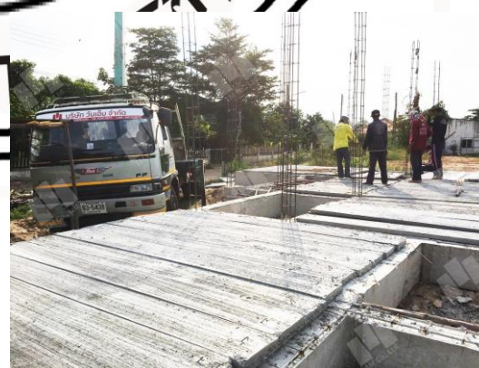
ข. การวางพื้นคอนกรีตสำเร็จรูป
