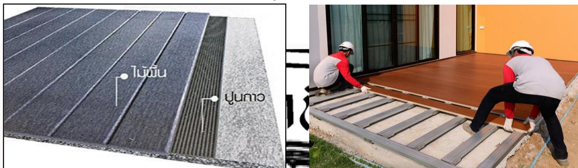
ก. การปูพื้นไฟเบอร์ซีเมนต์บนพื้นปูน ข. การปูพื้นไฟเบอร์ซีเมนต์บนโครงคร่าว รูปที่ 1.7 ภาพแสดงลักษณะของพื้นไฟเบอร์ซีเมนต์ ที่มา : https://www.maitipwatsadu.com
